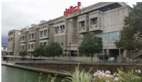
Centre national de la danse à Pantin
